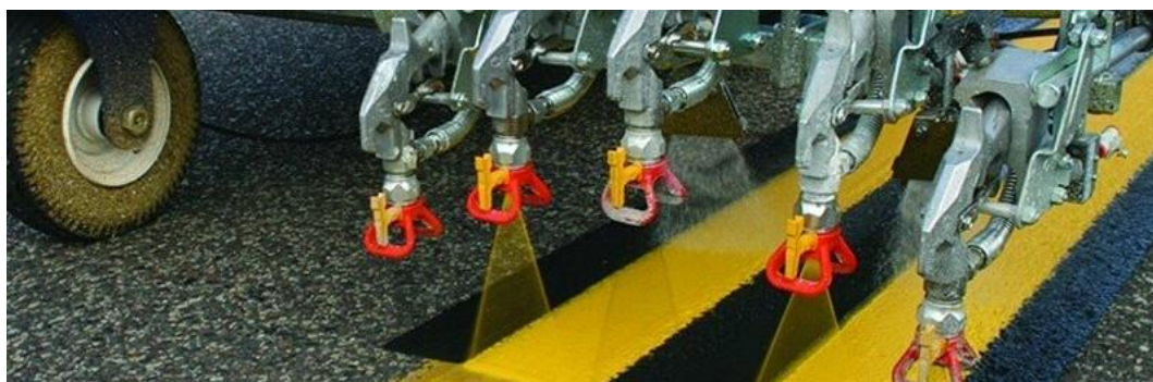
Рисунок 3.36 – Нанесение дорожной разметки
