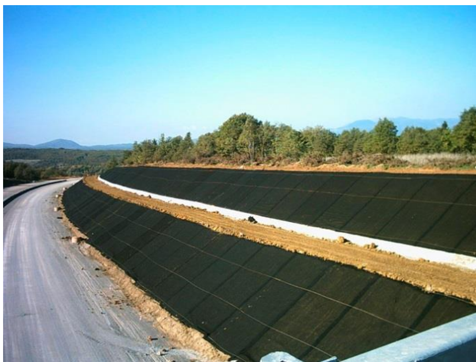
Рисунок 3.20 – Укрепление откосов георешеткой
