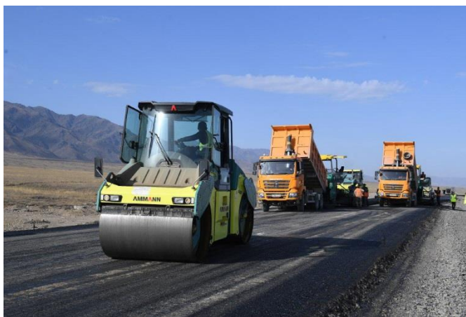
Рисунок 3.37 – Ремонт автомобильной дороги
