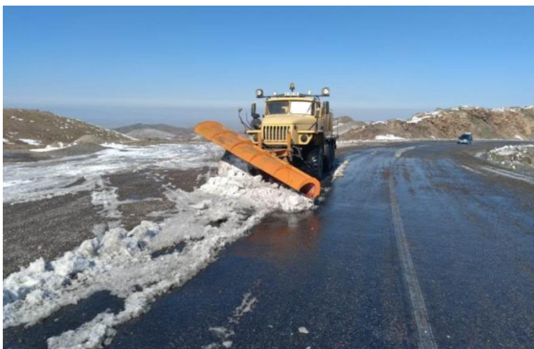
Рисунок 3.39 – Очистка дороги от снега
