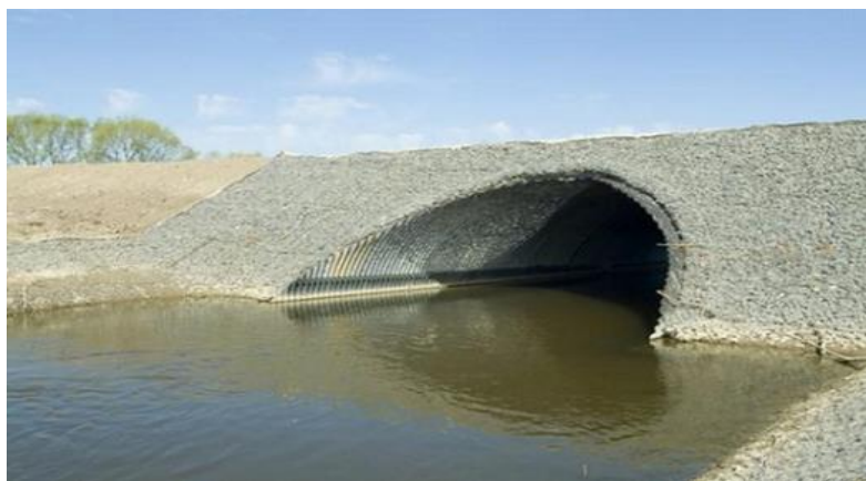
Рисунок 1.6 – Металлическая водопропускная труба
