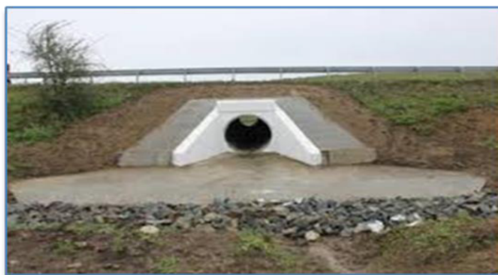
Рисунок 1.4 – Круглая железобетонная труба
