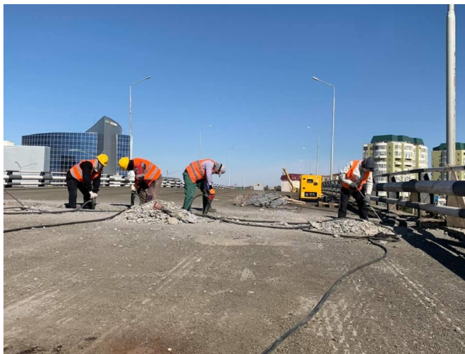
Рисунок 3.38 – Ремонт моста автомобильной дороги
